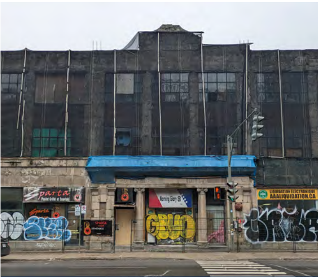
Façade partiellement démantelée (4030, rue Sainte-Catherine) identifiée comme bâtiment patrimonial de catégorie 1 (exceptionnel) Partially Deconstructed Facade (4030 Sainte-Catherine Street) Identified as a Category 1 (exceptional) heritage building
