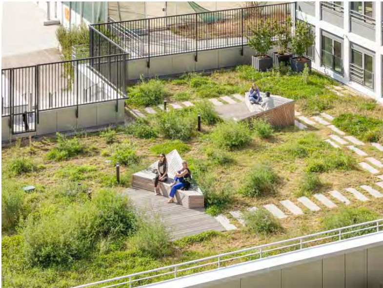
Toiture végétalisée - projet immobilier Green Roof - Real Estate Project
