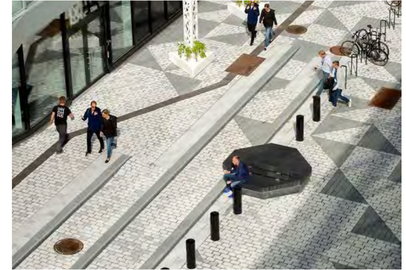
Continuité du traitement au sol invitant à réduction de la vitesse Continuous Ground Treatment Encouraging Traffic Calming
