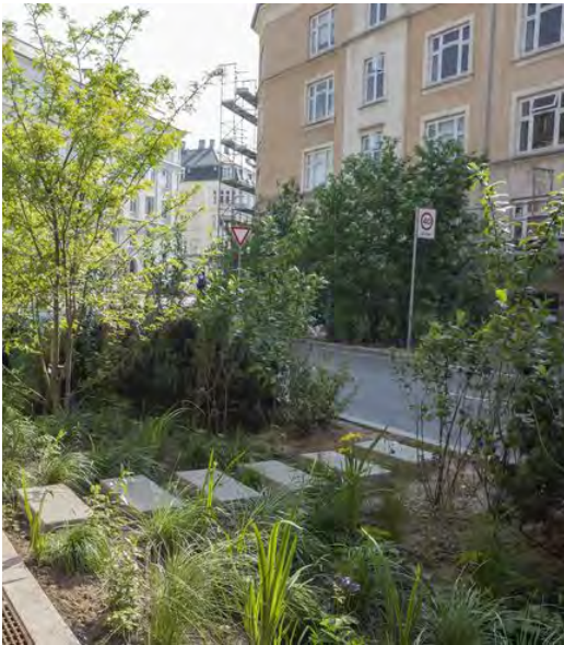
Noue drainante Drainage Ditch
