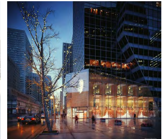
Mise en lumière Lighting Design
